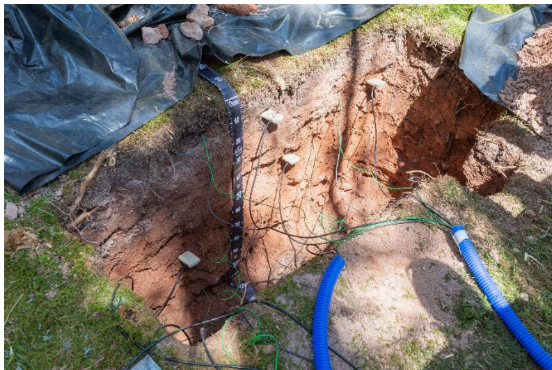
Fosse réalisée en 2022 pour l'installation de capteurs d'humidité, température et potentiel matriciel.
